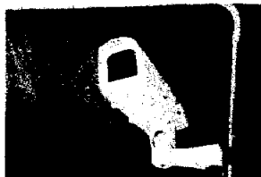
防犯カメラ設置
