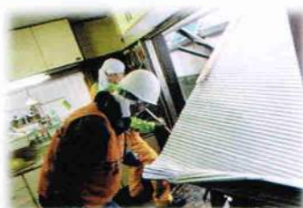
▲9月8日(火)トタン屋根の撤去作業
