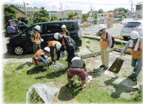
▲9月12日(土)がれき・ゴミの撤去作業
